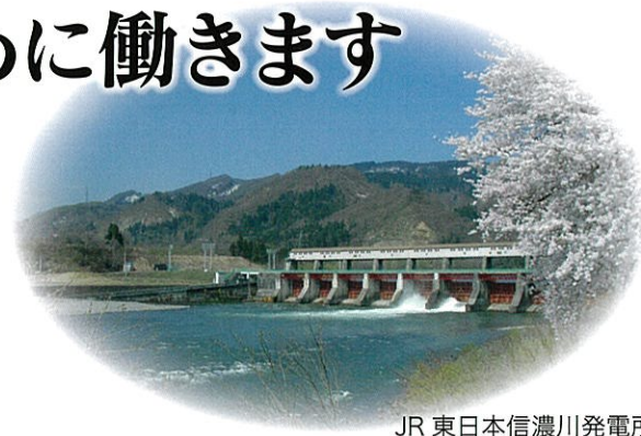
JR 東日本信濃川発電所 宮中取水ダム
