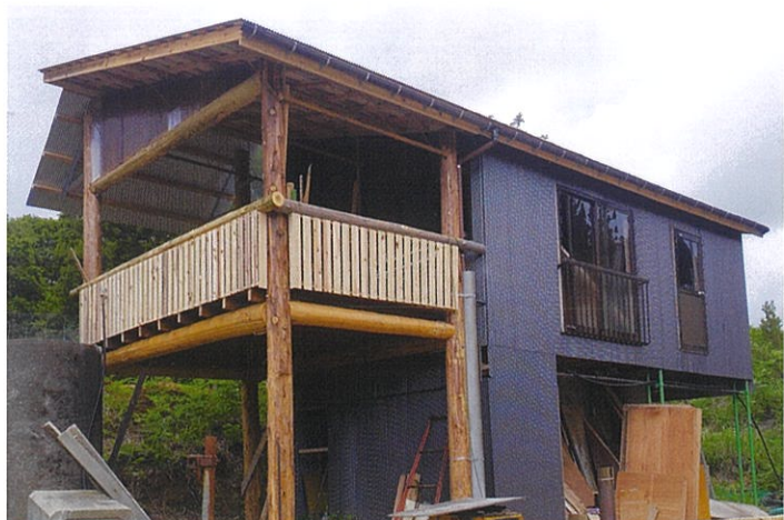
川西モトクロス場で建設中の山小屋
