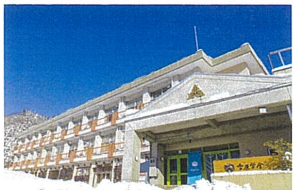
旧貝野小学校をリノベーションした「雪原学舎」
