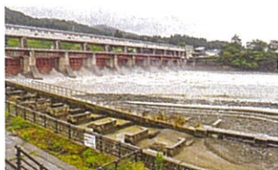
JR東日本信濃川発電所の宮中取水ゲム
